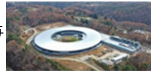
写真：次世代放射光施設（整備中）全景
