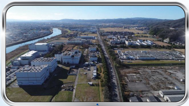
小矢部川流域下水道 二上浄化センター (高岡市二上地内)
