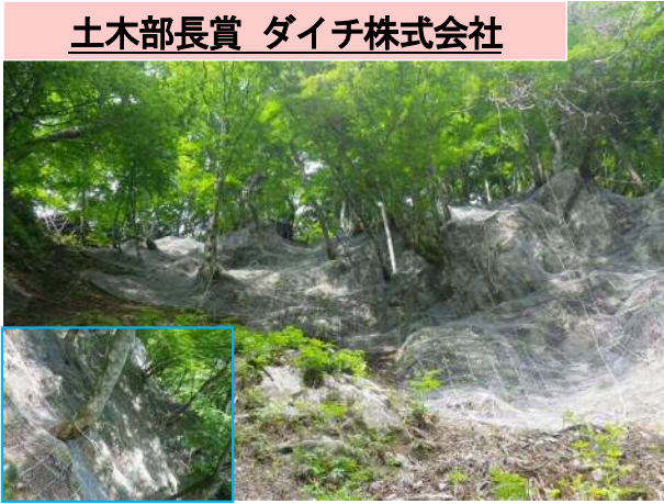
一般県道弘法称名立山停車場線道路総合交付金 (防災・災防・修繕) 落石防止工事…①
