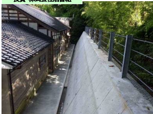
片地地区砂防総合交付金(急傾斜)緊急改築擁壁補修工事…⑦
