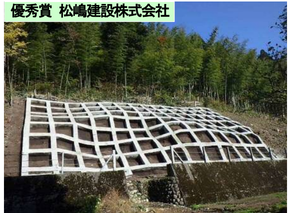
栢津地区砂防総合交付金(急傾斜)法面工事…④
