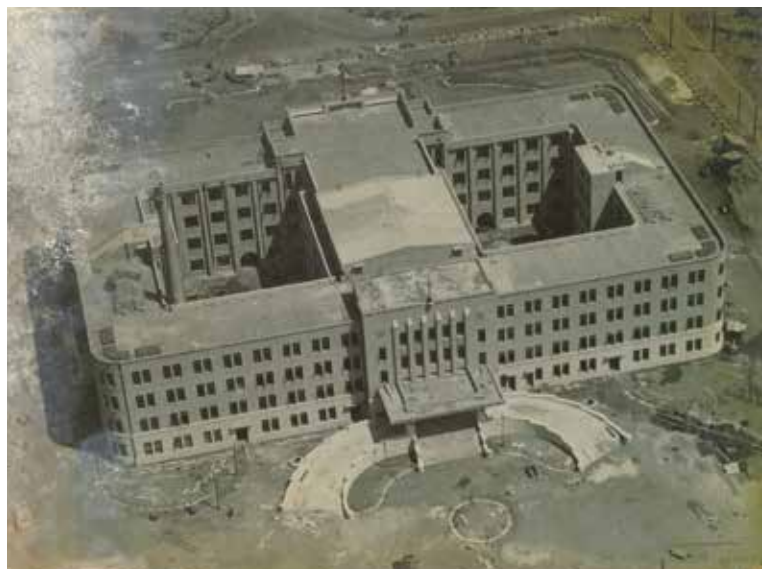
昭和10年8月竣工時写真(南側上空から)
