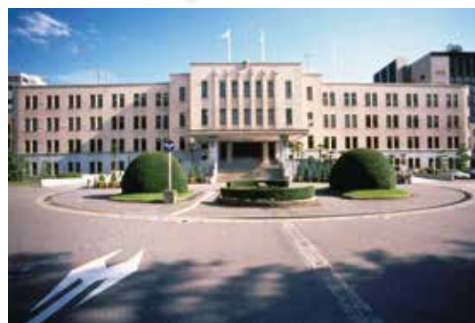
現在の県庁舎(北から)
