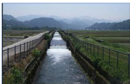
落差を有する農業用水路
