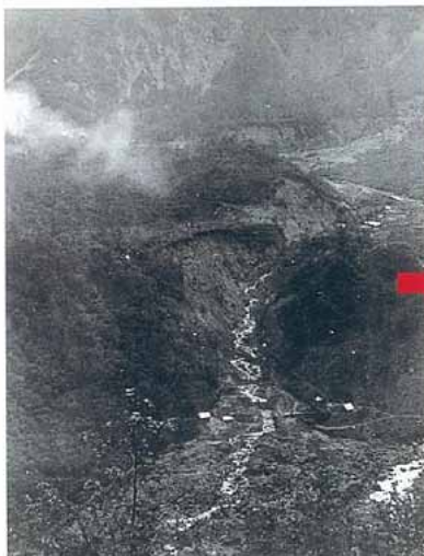
着工前の荒廃の著しかった泥谷。 1929年(昭和4)撮影。
