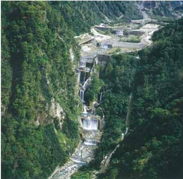
立山カルデラを護る重要文化財「白岩砂防堰堤」
