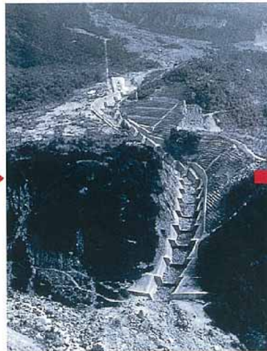
階段式砂防ダム群と山腹工を組み合わせた砂防 工事が行われた1933年(昭和8)。
