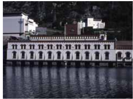
水力発電施設（ノルウェー）
