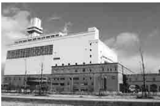
発電付焼却炉
