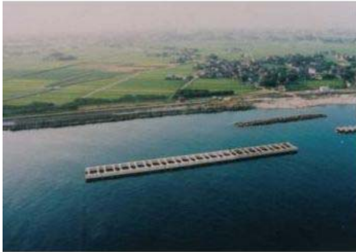
有脚式離岸堤
