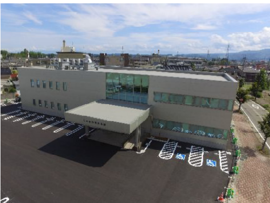
(庄川合口用水会館 全景)
