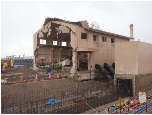
◆復旧途中の排水機場
